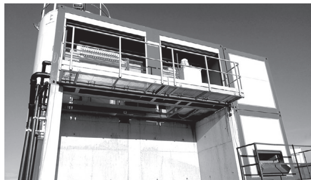
Abwasserbehandlung – Implenia – Ligne 17 – Paris
